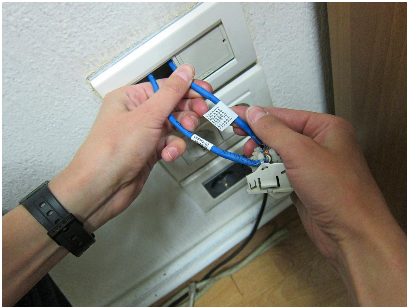
Рисунок 2. Маркировка провода
